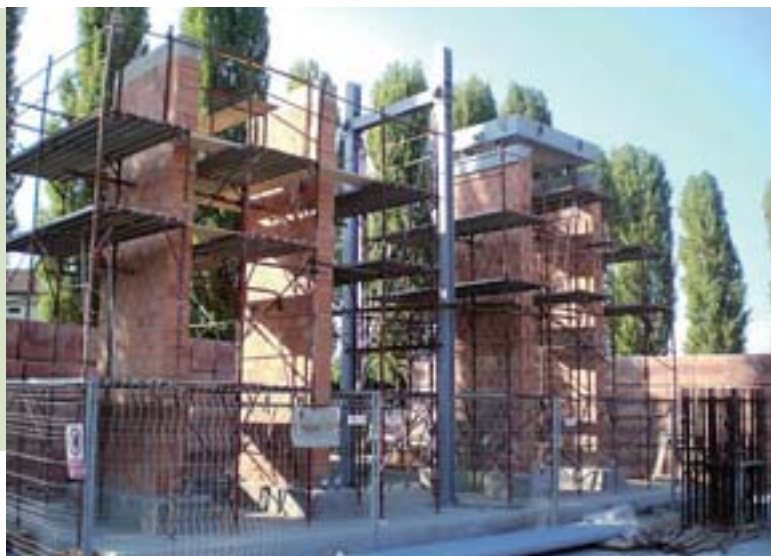
Fig. 10 - Sistema di muratura armata CIS Edil: realizzazione delle pareti in scala reale a Luzzara (BS) e strumentazioni di prova.
